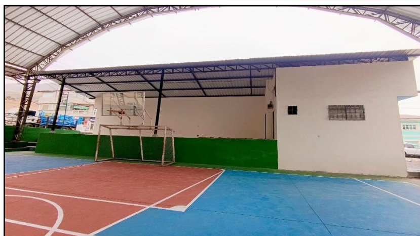
Fotografía 09: Mantenimiento Correctivo y Preventivo de los Espacios Públicos
