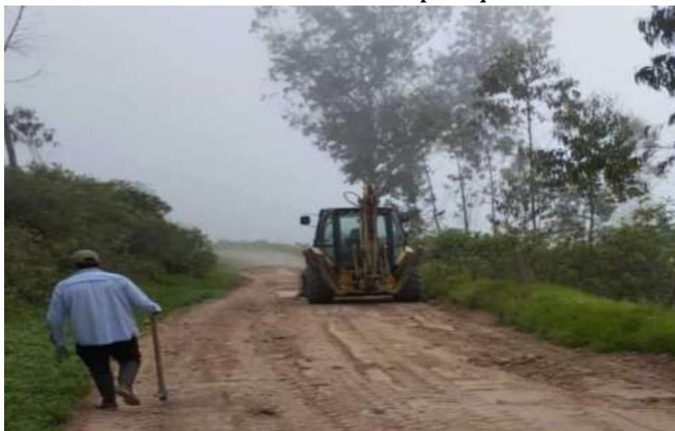
Fotografía 04: Trabajos de limpieza y mantenimiento de la red vial
